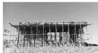
屋顶施工 Roof construction
